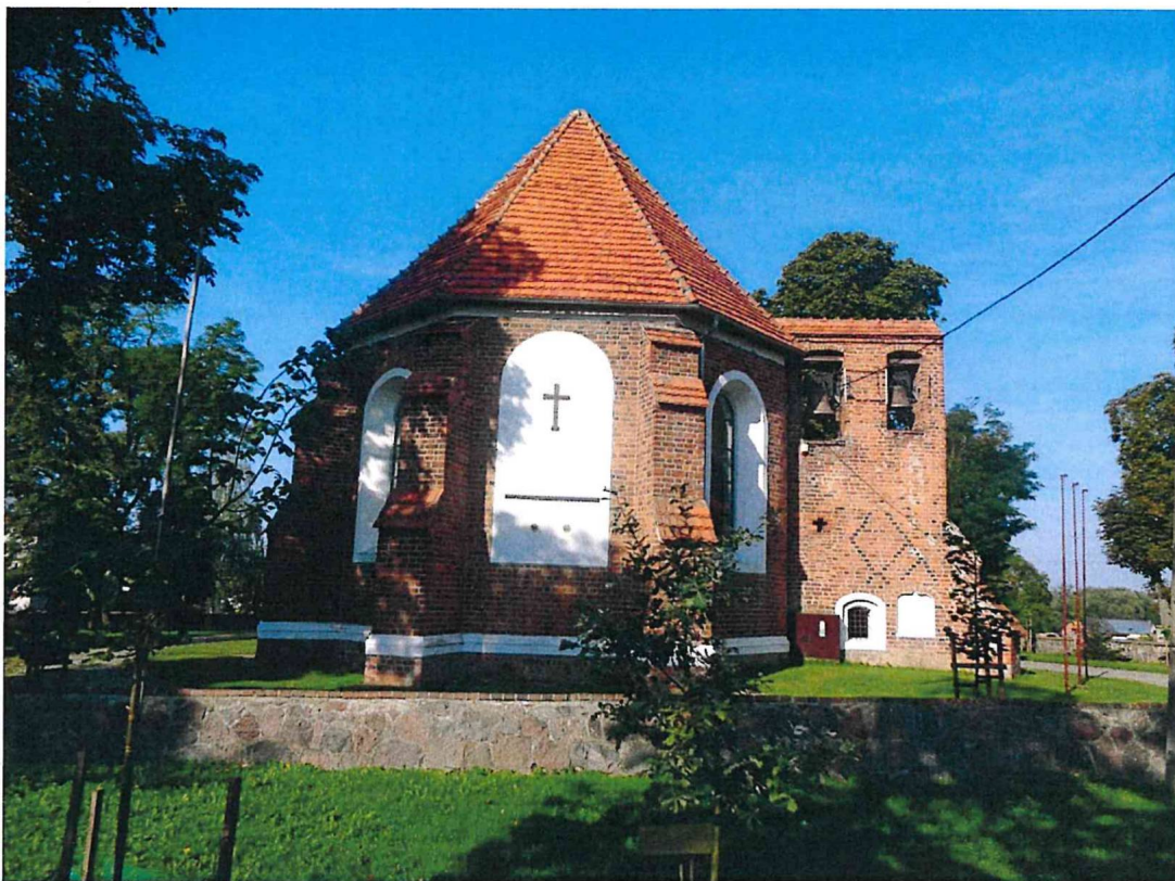
Fot. nr 2 Widok elewacja/dach od strony wschodniej
