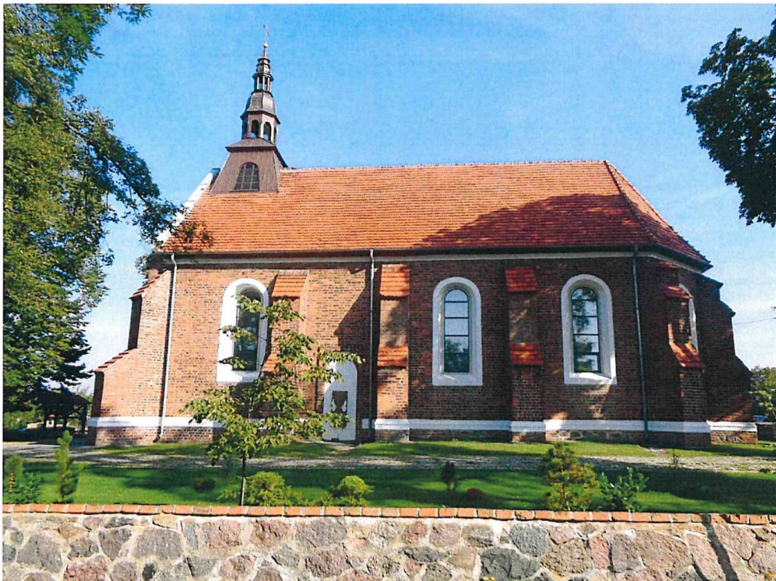
Fot. nr 4 Widok elewacja/dach od strony południowej
