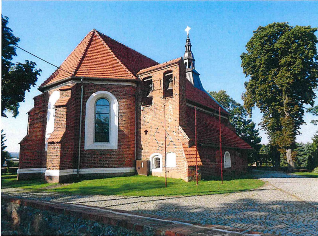
Fot. nr 1 Widok elewacja/dach od strony północno –wschodniej od bramy wjazdowej
