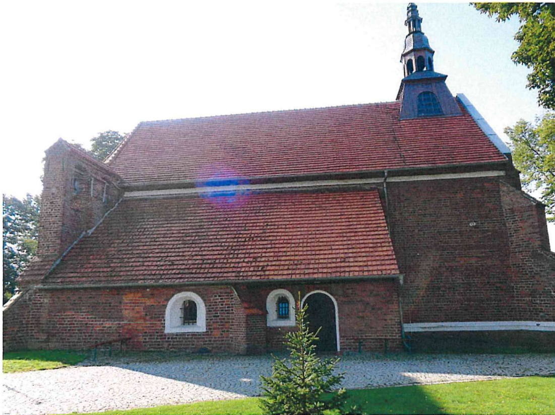
Fot. nr 3 Widok elewacja/dach od strony północnej
