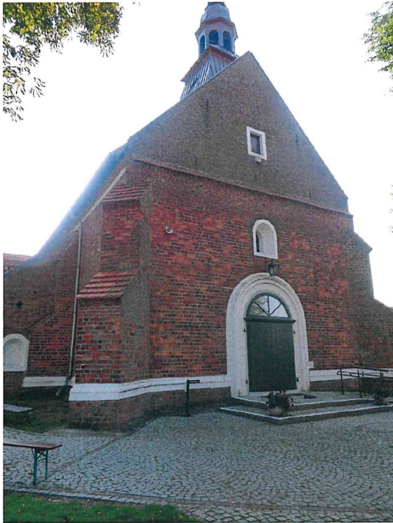
Fot. nr 5 Widok elewacja/dach od strony południowo-zachodniej – wejście główne
