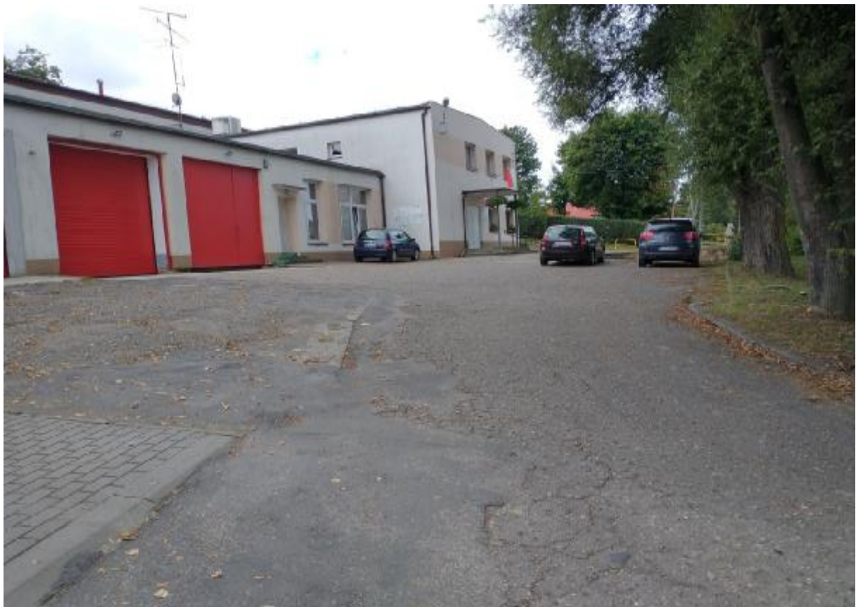
Część przylegająca do budynku Remizy strażackiej wykonana jest z asfaltu.;
