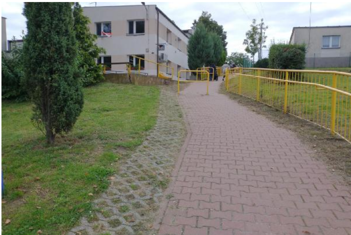
Wzdłuż zachodniej granicy,(Fot- powyżej,) - przebiega chodnik z pochylniami wykonany z kostki betonowej barwionej oraz jednostronnymi barierami;
