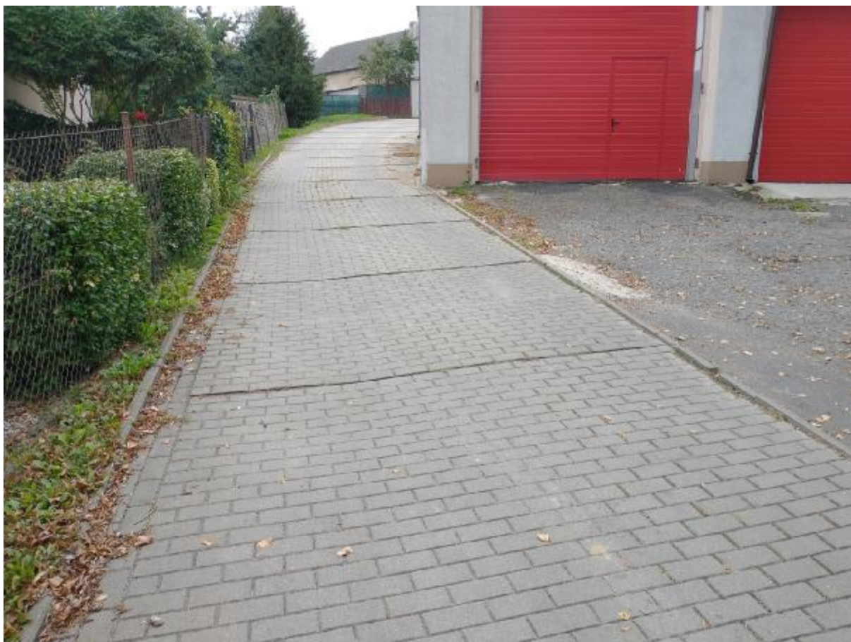
Zjazd na DW186 – ul. Główna. Z lewej – północny krawężnik drogowy do rozbiórki z przeznaczeniem na gruz do wtórnego użycia.
