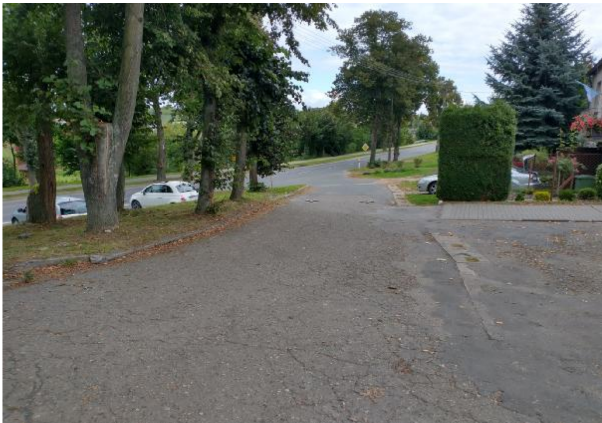
Zjazd na DW186 – ul. Główna. Z lewej – północny krawężnik drogowy do rozbiórki z przeznaczeniem na gruz do wtórnego użycia.
