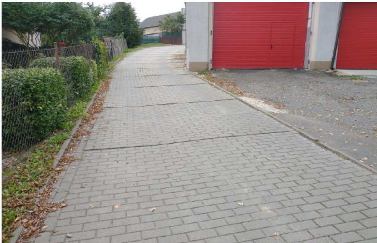
Droga wewnętrzna biegnąca równoległe do wschodniej granicy wykonana jest z kostki betonowej w obramowaniu obrzeżem chodnikowym;
